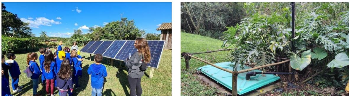
**Figura 35.** Programa de tecnologias ambientalmente amigáveis: **1.** Os painéis solares sustentam as edificações e servem como ferramenta de educação ambiental; **2.** MonoETE de tratamento de águas negras e bacias de evapotranspiração para tratamento de águas cinzas.
