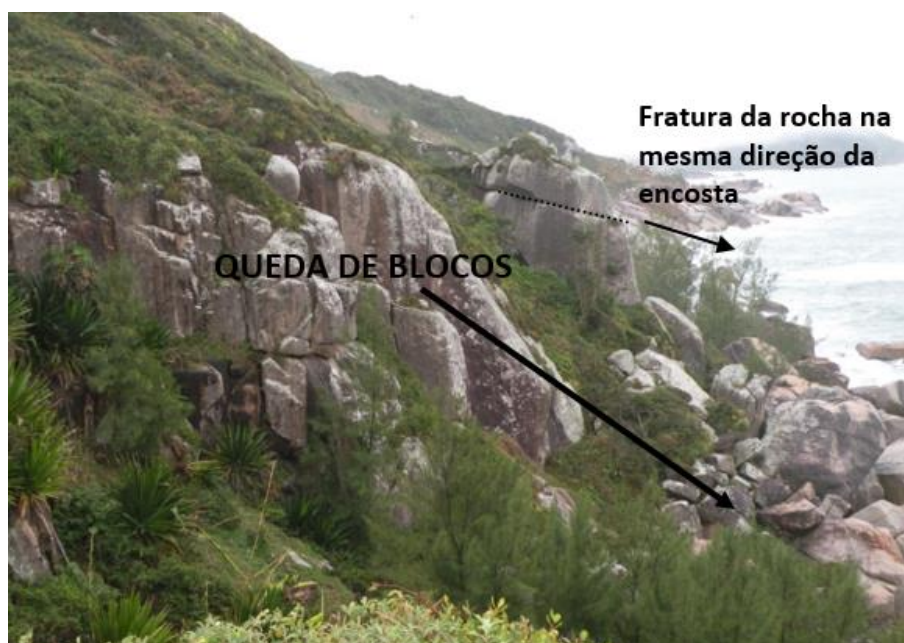
Figura 04. Setores com risco a movimentos de massa: queda de bloco. Arquivo Projeto Gaia Village.
