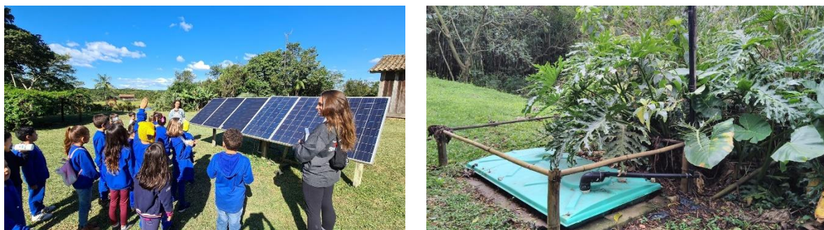
Figura 35. Programa de tecnologias ambientalmente amigáveis: 1. Os painéis solares sustentam as edificações e servem como ferramenta de educação ambiental; 2. MonoETE de tratamento de águas negras e bacias de evapotranspiração para tratamento de águas cinzas.
